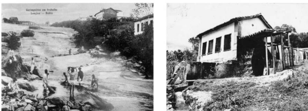
Figura 21 –À esquerda e direita, vistas das lapidações movidas a força hidráulica(SANTOS, 2006).
