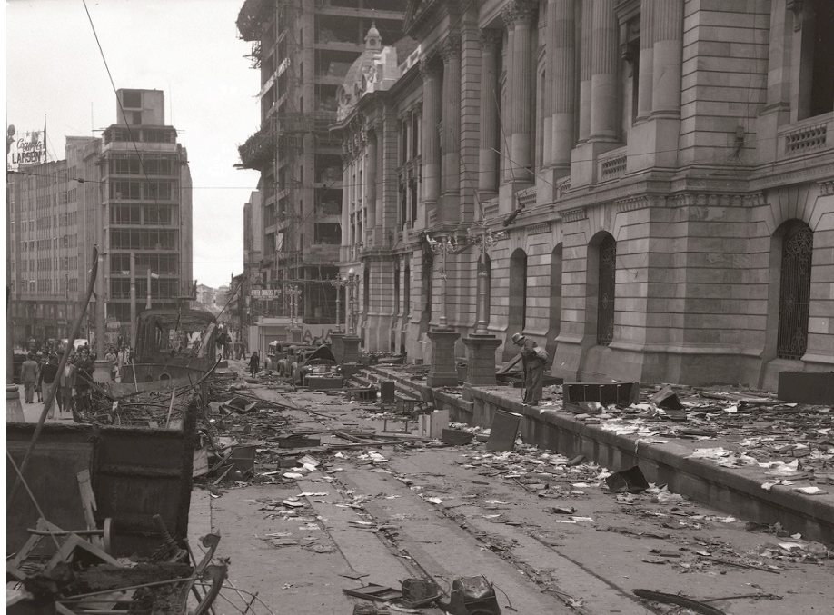
Figura 2. Destrozos en la Gobernación
