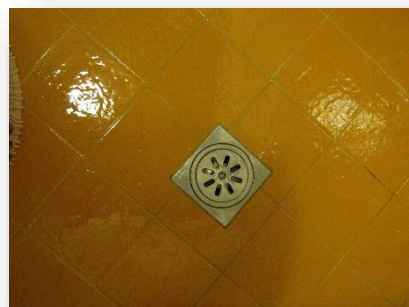
Scolo a pavimento.
