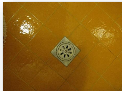
Scolo a pavimento.
